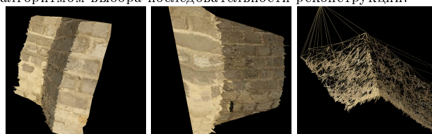
(c) Трехмерная модель (сеточная и текстурированная) с разных ракурсов, полученная в соответствии алгоритмом [2] выбора последовательности реконструкции.
